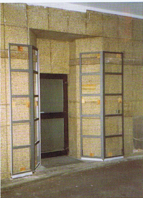
Bild 5.: Besonders durch den Autoverkehr gefährdete Bereiche, wie der Seiteneingang ...
