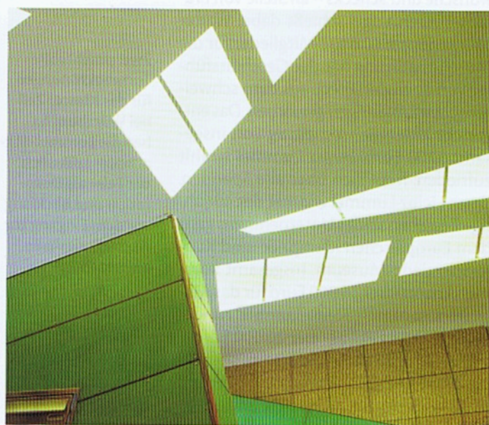
Bild 10.: ... für eine Verstärkung der dynamischen Gestaltung und tauchen die Durchfahrt in freundliches Licht. Die konischen Lichtdeckenfelder zeigen den Autofahrern die richtige Richtung.
