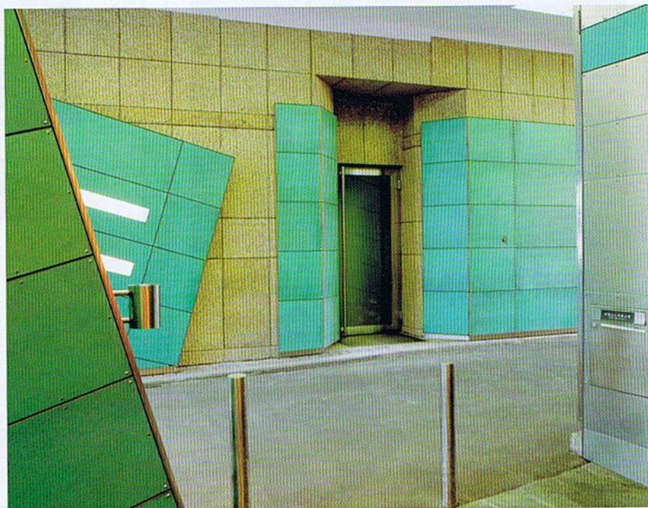
Bild 6.: ... sind durch kupferbekleidete Platten geschützt, die sich durch die Verwendung von Imbusschrauben leicht auswechseln lassen.
